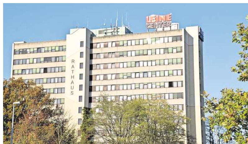
Brandschutzmängel: Ein Verbleiben im Rathaus im derzeitigen baulichen Zustand ist aus Sicht der Stadtverwaltung nicht möglich. FOTO: JOHANNES DORNDORF
